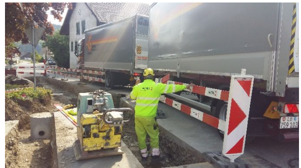
Abb. 6: Werkleitungsarbeiten alte Seonerstrasse
