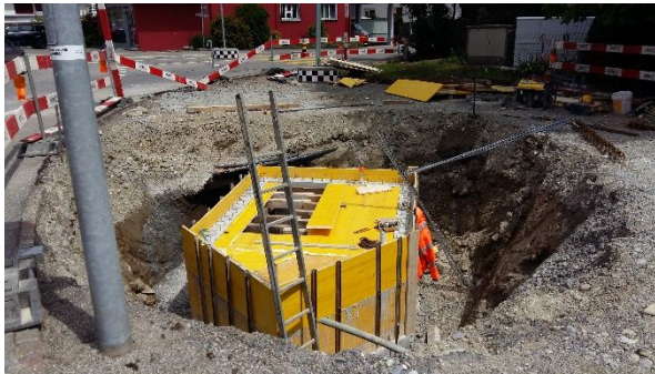
Abb. 3: Erstellung EW Schacht Nr. 3
