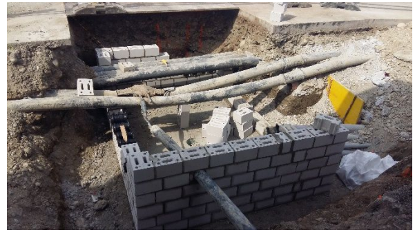
Abb. 4: Erstellung EW Schacht Nr. 1
