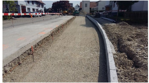
Abb. 2: Randabschlüsse BHS Milchgasse West
