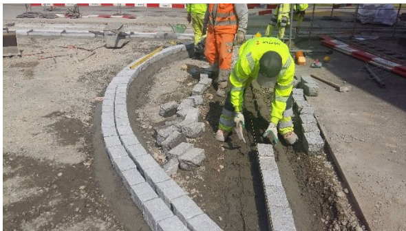
Abb. 5: Setzen der Randsteine bei der Talgasse
