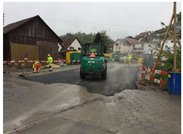
Abb. 4: Provisorischer Belag Installationsplatz
