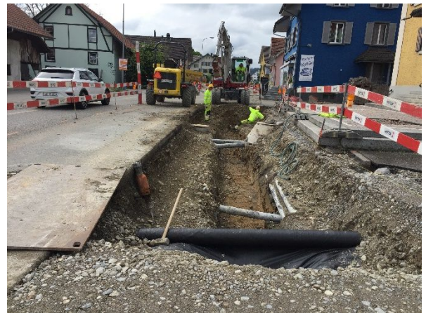
Abb. 2: Werkleitungsarbeiten Höhe Mehrzweckhalle
