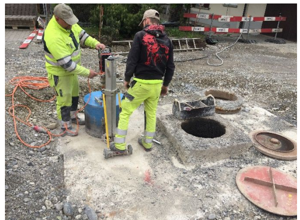
Abb. 6: Anpassungsarbeiten Swisscomschacht
