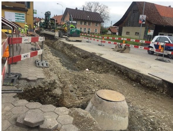
Abb. 1: Werkleitungsarbeiten Höhe Restaurant Mekong
