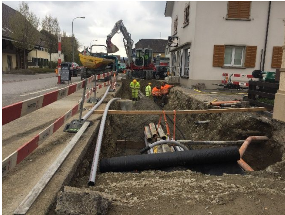
Abb. 1: Werkleitungsarbeiten West Höhe Seetalstr. 100
