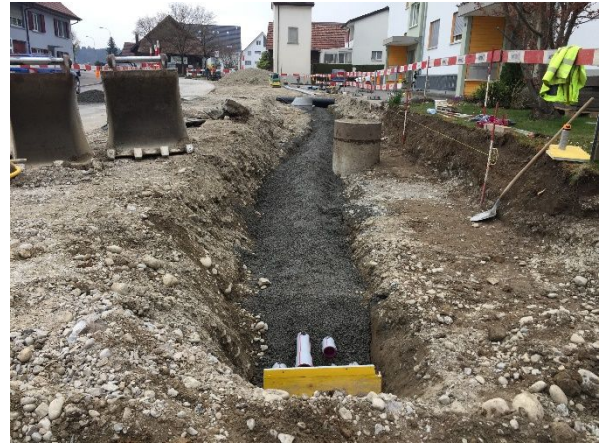
Abb. 2: Werkleitungsarbeiten West Höhe Seetalstr. 140
