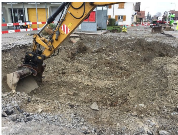
Abb. 5: Abbruch Waage Gemeindeplatz
