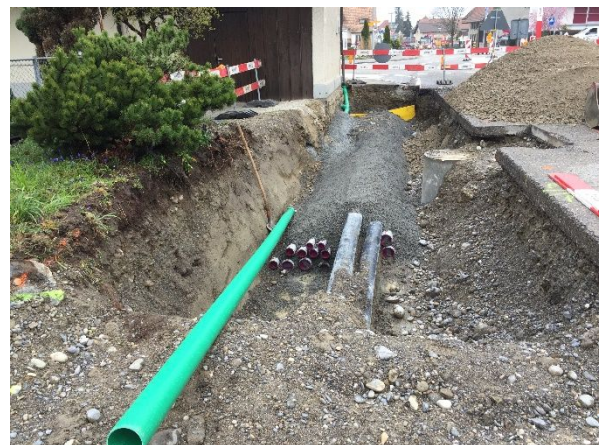
Abb. 5: Verlegung neuer Werkleitungen
