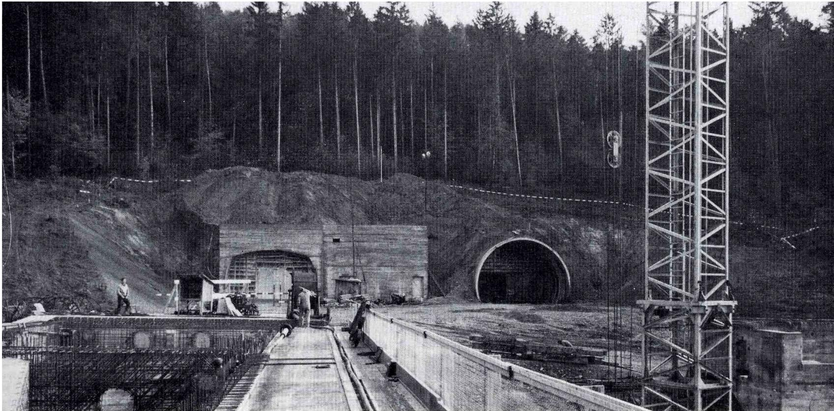
Abb. 6 Westportal des Tunnels; im Vordergrund die im Bau befindliche Autobahnbrücke Dättwil
