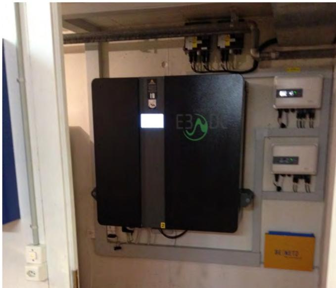
**PV = 18 kWp    Batteriekapazität 16 kWh**
