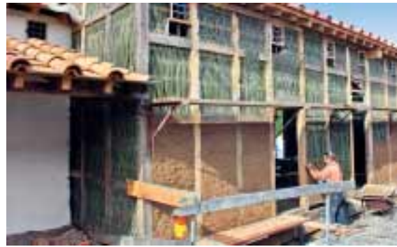
In monatelanger Handarbeit wurden die Legionärsunterkünfte aus Eichenbalken, Flechtwerk, Lehm und Kalk errichtet.
