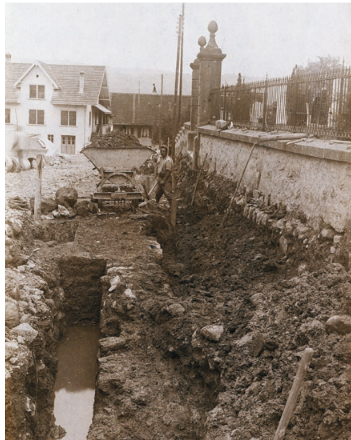
Bei der Erneuerung der Dorfstrasse (heute Schulstrasse) kamen 1922 Mauerzüge und ein Boden aus Ziegelplatten zum Vorschein. Wahrscheinlich gehören sie zu einem Wirtschaftsgebäude.
