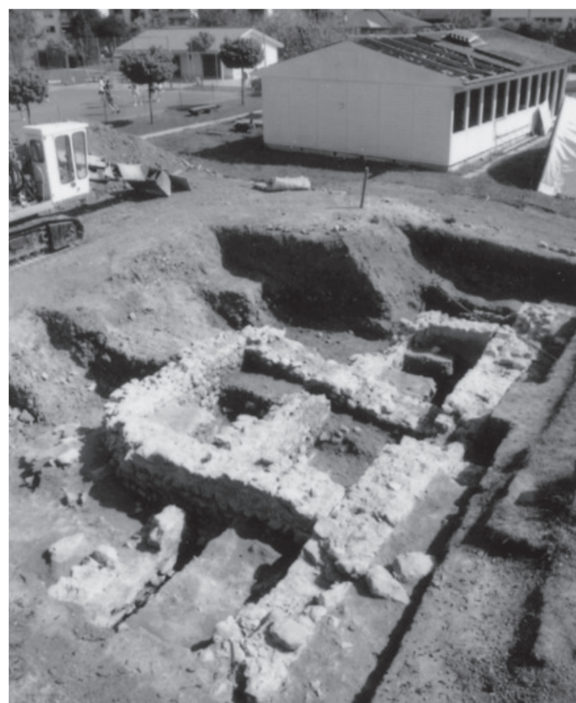
1998 konnte beim Bau des Kirchgemeindehauses die Nordfassade des Herrenhauses gefasst werden. Das Gebäude wurde knapp 100 Jahre benutzt und mehrfach umgebaut.
