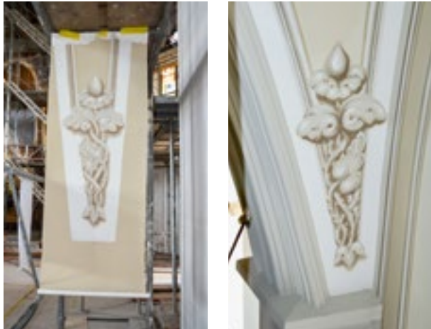
Einblicke in den Prozess der Restaurierung: Entwürfe der Dekorationsmalerei wurden zuvor auf Papier angefertigt. Details einer sogenannten Zwickelpartie des Langhausgewölbes im Entwurf (links) und ausgeführt (rechts) .
