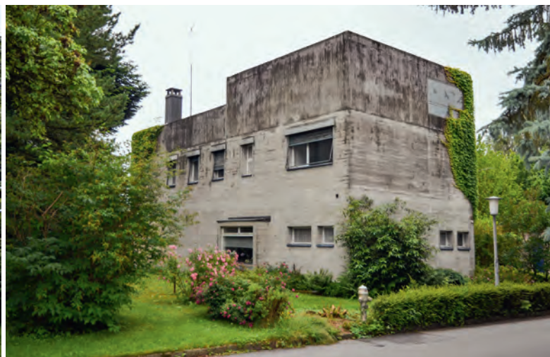
Ost- und Nordfassade. (Foto 2018: © Kantonale Denkmalpflege Aargau)
