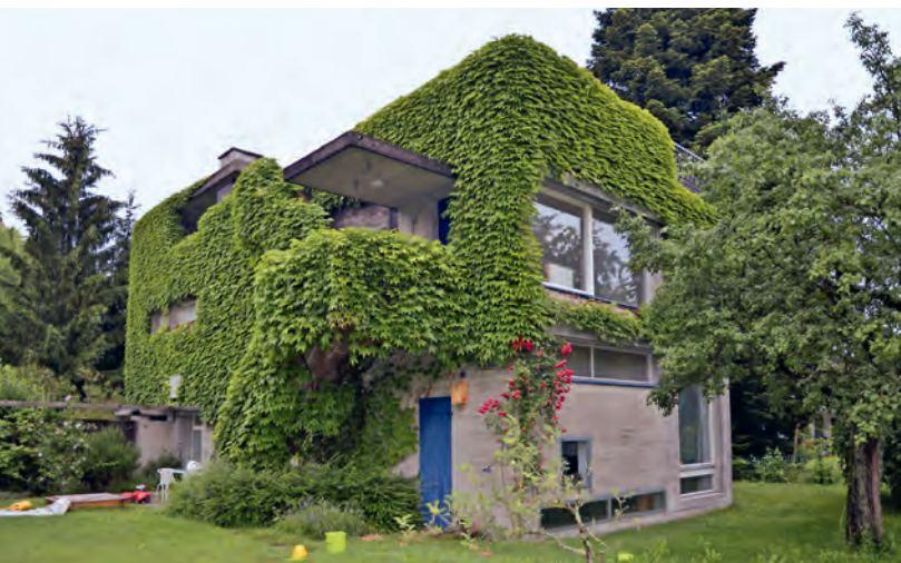
West- und Südfassade. (Foto 2018: © Kantonale Denkmalpflege Aargau)
