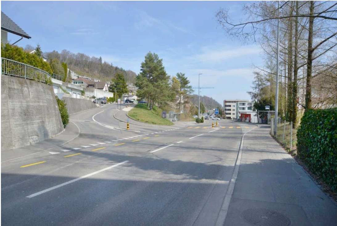
Bushaltestelle, Stützmauer und Grünstruktur bei der Einmündung Sugenreben
