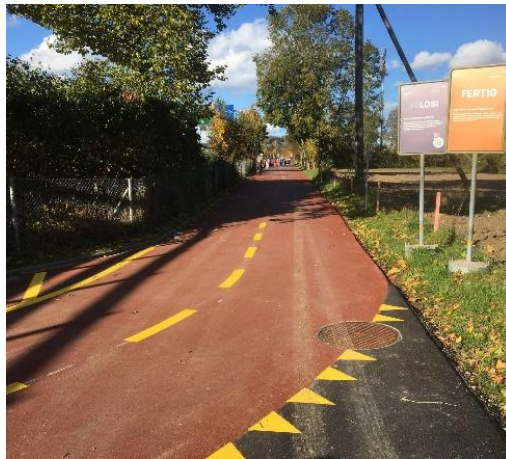
Abbildung 50: Eingefärbter Belag auf Velorouten (Bsp. Winterthur)
