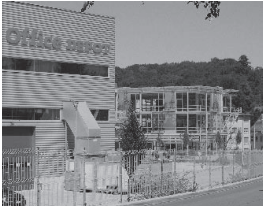
Im rechten Gebäude im ersten Stock: Das temporäre RAV in Lenzburg.
