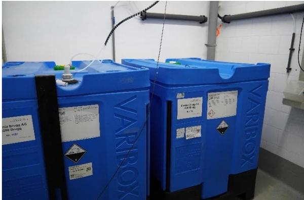
Abb. 10: Auch die Lagerung und Kennzeichnung der Schwefelsäure wird inspiziert.
