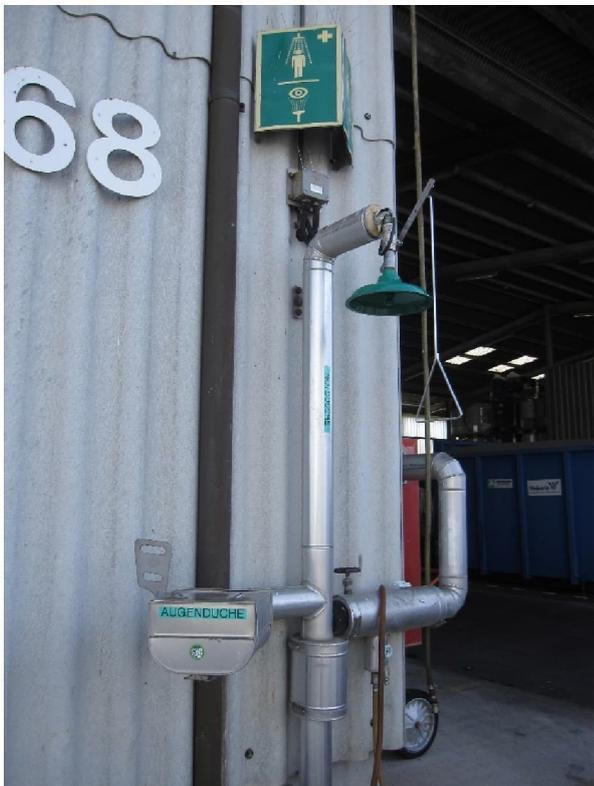
Abb. 36: Bei einem Störfall mit ätzenden Chemikalien sind Augenduschen für den Schutz der Mitarbeitenden wichtig.
