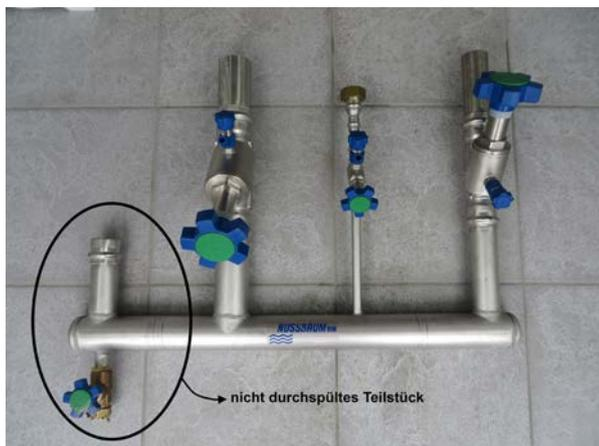
Abb. 8: Bei der Legionellen-Sanierung musste ein nicht durchspültes Warmwasser-Leitungsteil abgetrennt werden, da sich Legionellen darin vermehren und zur Rekontamination des Warmwassersystems führen konnten.
