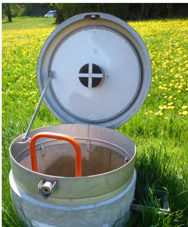
Abb. 7: Brunnstube einer kommunalen Wasserversorgung
