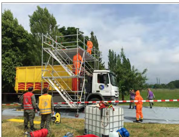
Abb. 1: Errichtung einer Deko-Stelle für Grossfahrzeuge
