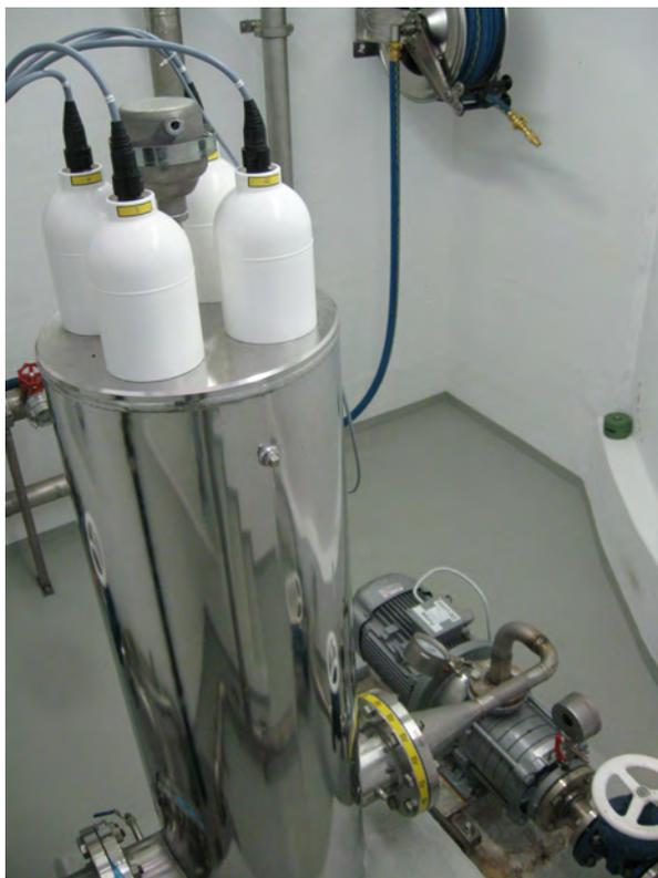
Abb. 6: UV-Anlage mit 4 Strahlern
