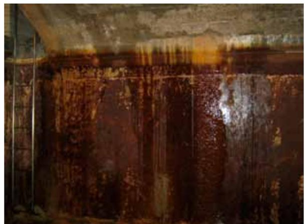
Abb. 16: Nach starken Niederschlägen (natürlich sowie Beregnung aus Tanklöschfahrzeug) sind deutliche Einsickerungen in eine Wasserkammer zu erkennen. Auf diesem Weg gelangten Fäkalkeime ins Trinkwasser.
