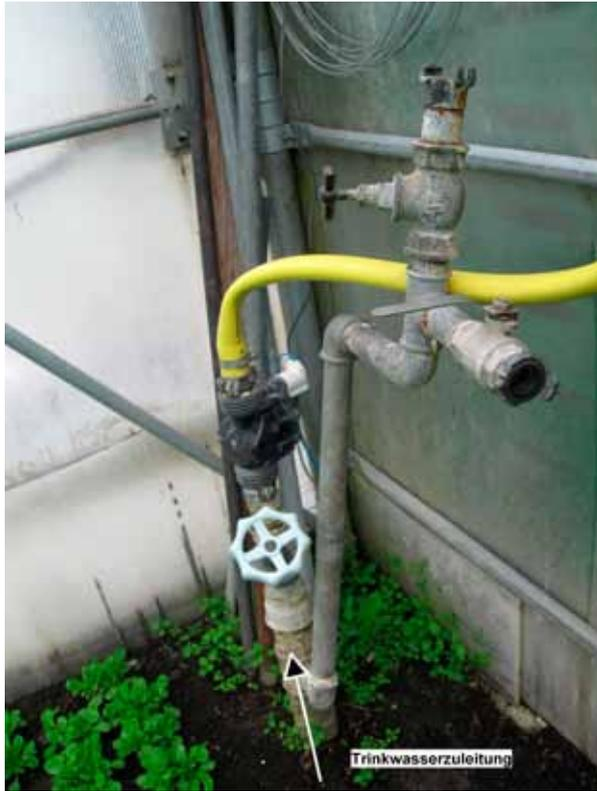
Abb. 19: Ungenügende Netztrennung in der Bewässerungsanlage eines Frischgemüse-Gewächshauses. Die Installation musste mit einem geeigneten Systemtrenngerät von der Trinkwasserleitung abgekoppelt werden, so dass kein chemikalienhaltiges Bewässerungswasser mehr in die Trinkwasserleitung gelangen konnte.
