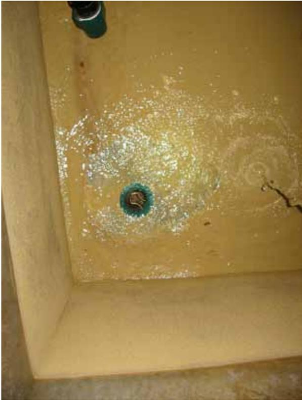
Abb. 18: Die Ableitung zur Entleerung des Absetzbeckens ist zu klein dimensioniert. Die Quellschüttung dieser nicht mehr genutzten Fassung stieg nach starken Niederschlägen so stark an, dass das Absetzbecken überlief und verunreinigtes Wasser in das danebenliegende Becken einer Trinkwasserfassung gelangte.
