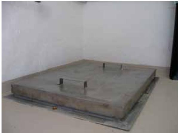
Abb. 17: Zur zusätzlichen Sicherung gegen unbefugten Zugang wurde eine Wasserkammerabdeckung dieser Bauart in einem Reservoir von einem Schlosser mit einem Zylinderschloss nachgerüstet. Dabei wurde übersehen, dass der Deckel nach dieser Änderung nicht mehr auf der Dichtung, sondern auf dem Stutzen des Zylinderschlosses auflag. Lösungsmitteldämpfe wurden auf diesem Weg in die Wasserkammer gesaugt. Weil der Deckel über die Bördelkanten hinab führt, ist dieser Defekt äusserlich nicht zu erkennen.
