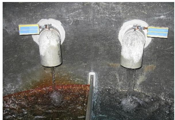
Abb. 20: Augenfällige, braune Ablagerungen im Absetzbecken einer Quelle durch ausfallendes Eisen und Mangan aus Gesteinsschichten.
