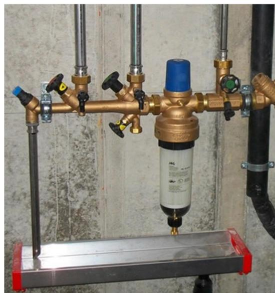
**Abbildung 16:** Beispiel einer Hausinstallation mit Filterkartusche.
