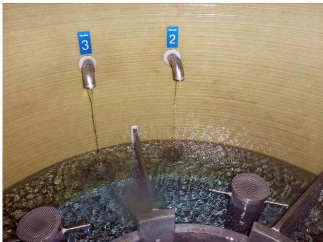
**Abbildung 1:** Mehr als die Hälfte der untersuchten Proben betreffen Trinkwasser. Im Bild zu sehen sind zwei Quelleinläufe in der Brunnenstube.
