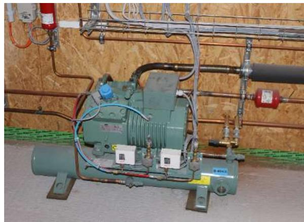
**Abbildung 27:** Kälteerzeugende Maschine für einen Kühlraum in einem Landwirtschaftsbetrieb
