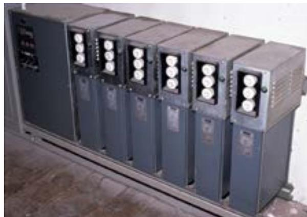
Abb. 5: Alte PCB-haltige Kompensationsanlage, wie sie in einem Industriebetrieb angetroffen werden kann. Sämtliche Kondensatoren sind einzeln vor Ort mit Sicherungselementen ausgerüstet. Solche Anlagen blieben bei der Erfassung zwischen 1990 und 1997 teilweise unentdeckt.
