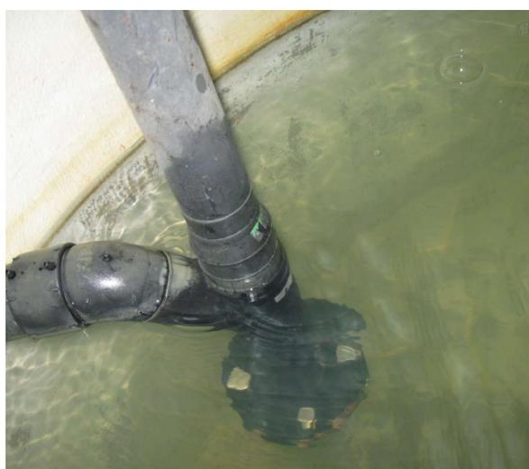
Trübes Wasser in Trinkwasseranlage nach starken Niederschlägen
