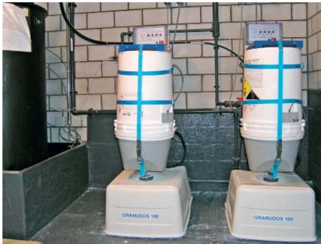
**Bild 1** Dosierstation für Calciumhypochlorit. Damit kann auf das Lagern und den Einsatz von Chlor in Druckbehältern verzichtet werden.
