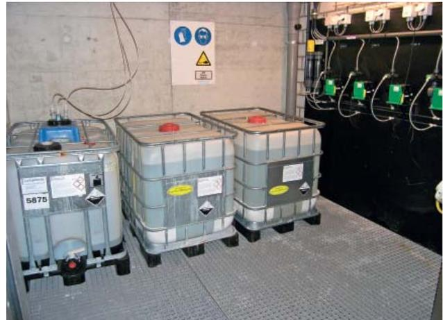
**Bild 3** Blick in den abgetrennten Raum für die Säuredosierung. Der Fussboden ist als Auffangwanne gestaltet; in der Ecke Abluftkanal der künstlichen Raumentlüftung.
