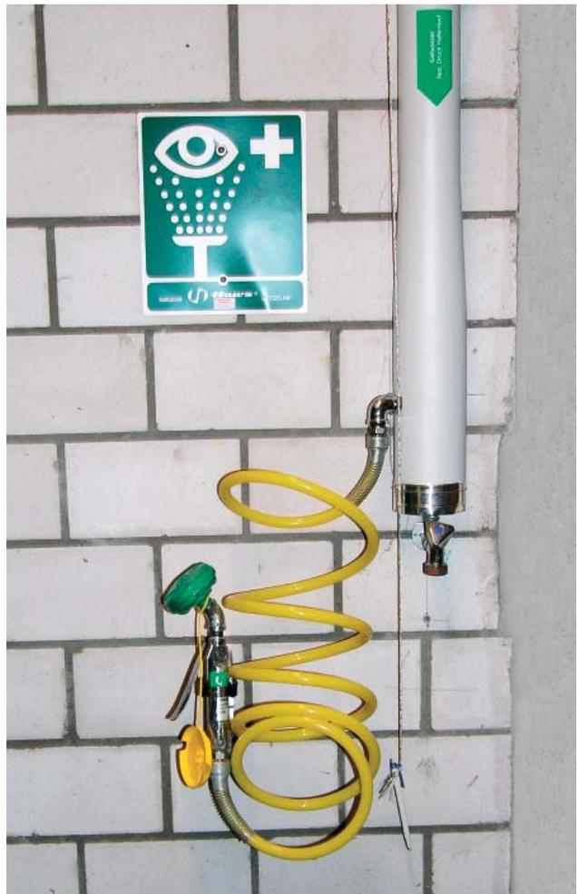
**Bild 4** Einrichtung für die Erste Hilfe im Säureraum.
