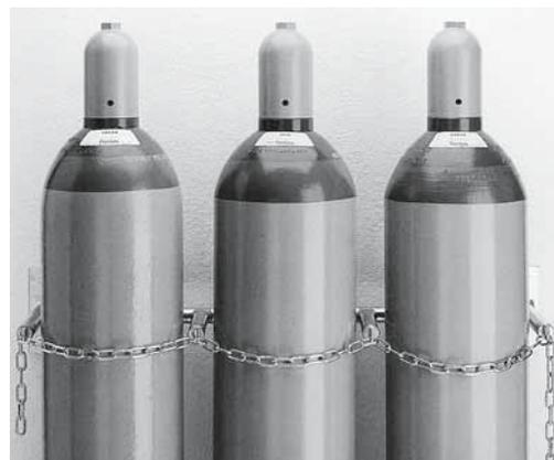
Bild 3: Sicherung der Gasflaschen mit Ketten.
