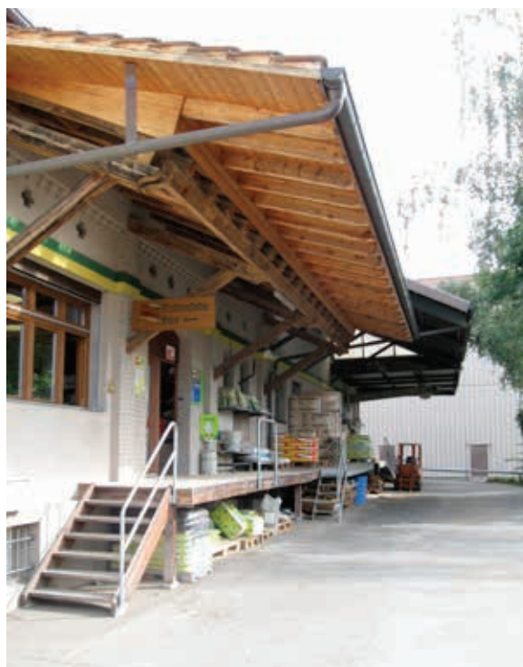
Ein Güterumschlagplatz muss überdacht, befestigt und abflusslos sein. Zusätzlich muss jederzeit Bindemittel bereit stehen.
