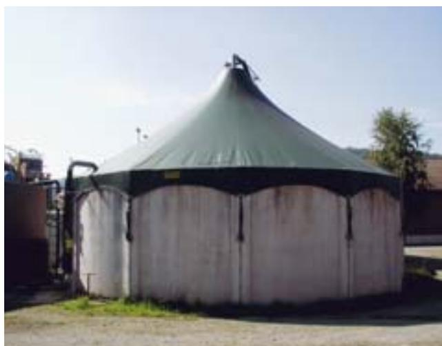
Abb. 1: Die Ammoniakemissionen eines offenen Güllebehälters (links) können durch eine Abdeckung (Zeltdach, rechts) deutlich verringert werden.
