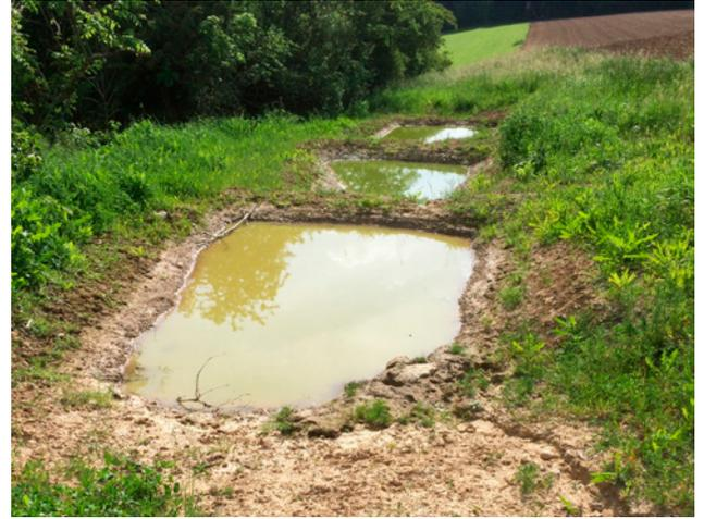
**Abdichtung bestehender, feuchter bis vernässter Mulden und Gräben** mit Vibroplatte, Ramax, Baggerschaufel. Fläche Umgebung gestalten ohne Wälle, sodass alles Wasser aus der Umgebung zulaufen kann. In Gräben untereinander gestaffelte Teilgewässer (Tümpelkette) erstellen mit Überlauf in unproblematische Flächen (Hecken, Säume etc.).
