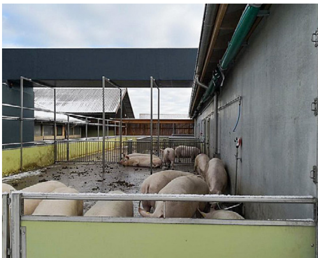
Abbildung 17: Beispiel einer Abluftreinigungsanlage für einen Schweinestall.
