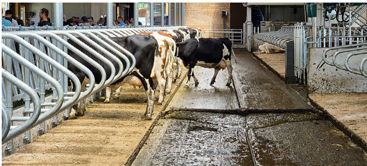
Abbildung 16: 3D-Gummimatte, von Bund und Forschung empfohlene Laufgangmatte mit drei Prozent Gefälle und erhöhter Fressauftritt mit Abtrennungen.
