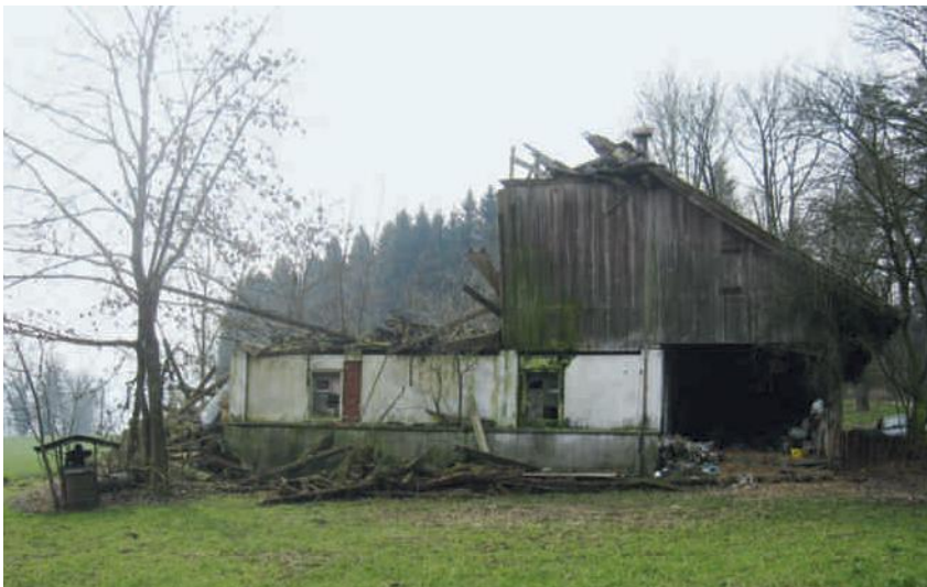
Der Gebäudezustand spielt eine wichtige Rolle bei der Beurteilung der Erhaltungswürdigkeit.
