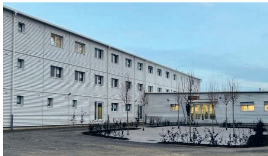
Kantonale Unterkunft in Oftringen
