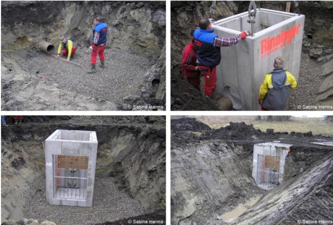
Abbildung 28: Bei einem Feuchtwald in Senken kann im Entwässerungsgraben z. B. ein Schacht eingebaut werden, um die Senke regulierbar einzustauen.
