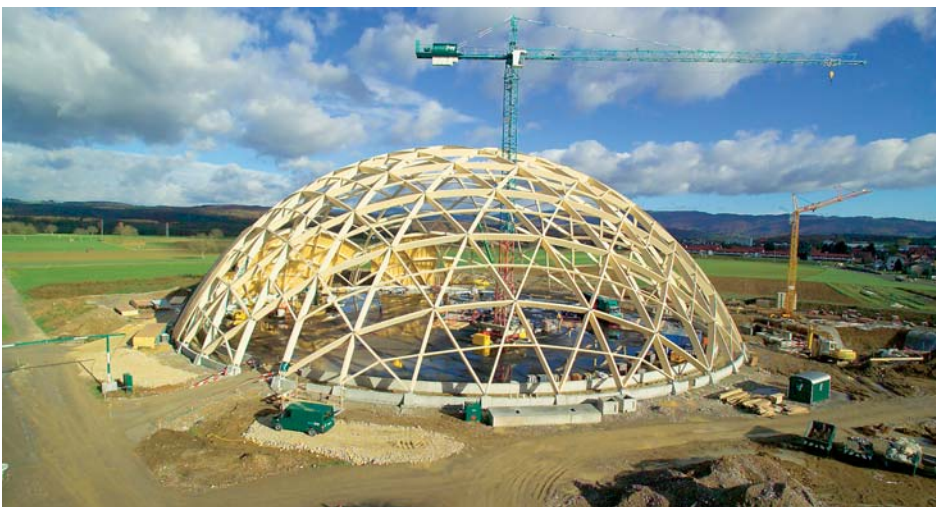
“Saldome” der Schweizer Rheinsaline in Rheinfelden: Die imposante Kuppel hat einen Durchmesser von 93 m und ist 31 m hoch.
