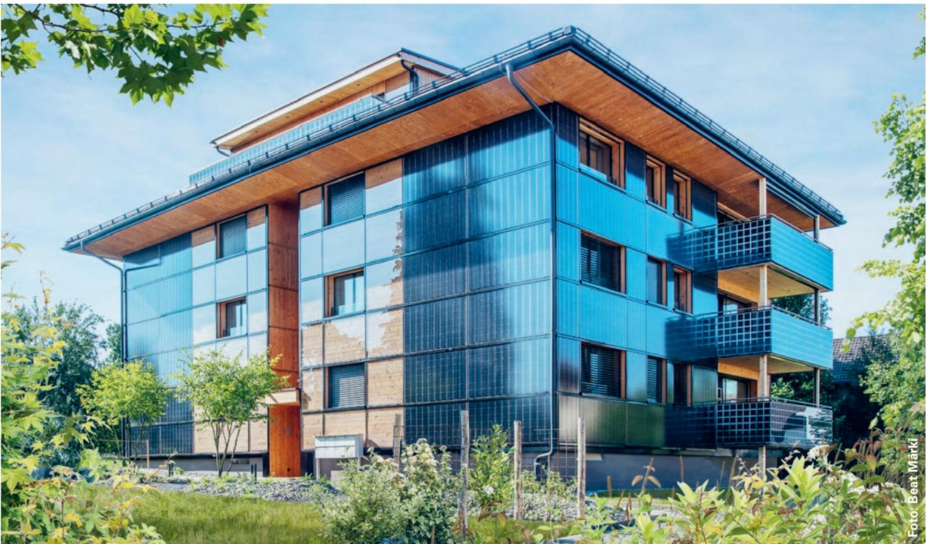
Bei diesem nach Minergie-P-Baustandard renovierten Mehrfamilienhaus in Fahrwangen sank der bisherige Gesamtenergiebedarf von 137'700 Kilowattstunden pro Jahr um 82 Prozent auf 24'700 Kilowattstunden pro Jahr. Die in die Gebäudehülle integrierte PV-Anlage generiert zusammen mit den PV-Balkonbrüstungen 78'000 Kilowattstunden pro Jahr. Damit entsteht jährlich ein Solarstromüberschuss von über 50'000 Kilowattstunden.
