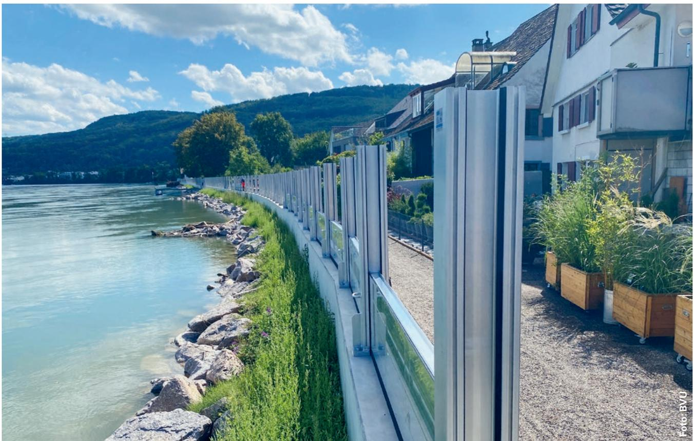
*Die Hochwasserschutzmauer in Wallbach kann mit Aluminiumelementen auf zwei Meter erhöht werden: so sieht zeitgemässer Hochwasserschutz aus.*
