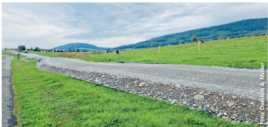
*Diese Baupiste besteht aus sauberem Kies, der direkt auf den gewachsenen, begrüntem und abgetrockneten Oberboden (Option Abtrennung beispielsweise mit Geotextil) geschüttet wird und im abgewalzten Zustand eine Mächtigkeit von 50 Zentimetern aufweisen muss. Witterungs- und bodenunabhängige Arbeiten und Transporte sind so jederzeit möglich.*
