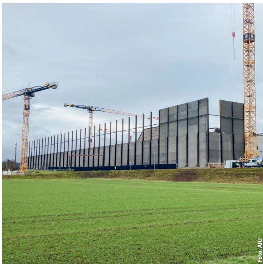
Stand der Arbeiten am 23. Dezember 2022 beim Bau der Lärmschutzwand beim Ersatzkraftwerk Birr. Teilweise ist die erforderliche Höhe von 20 Metern bereits erreicht.
