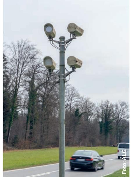
*Die Sensoren der Wildwarnanlagen reagieren bei einer minimalen Wärmedifferenz von 0,5 °C auf 250 Meter Entfernung und erfassen bewegende Wärmequellen ab einer Grösse eines Hasen verlässlich. Wird die Wärmequelle erkannt, werden Leuchten und Warntafeln am Strassenrand aktiviert.*
