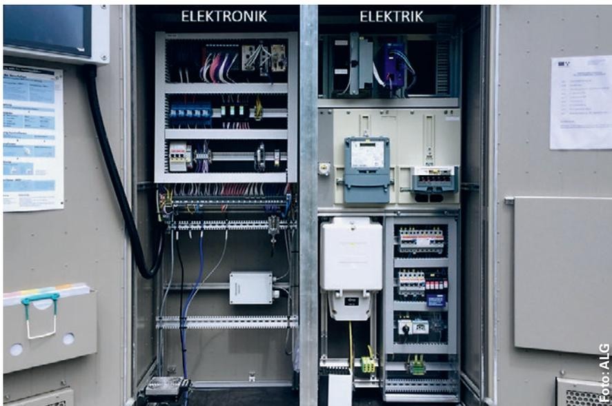
Standard-Elektroschrank für grössere Messstationen (A-Netz) nach der Aufrüstung: Dank der neuen Elektronik und Elektrik (höhere Rechenleistung und permanente Internetanbindung) melden die Stationen einerseits Störungen aktiv und automatisiert, andererseits ist so eine unkomplizierte Fernwartung möglich.
