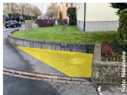
*Bei wenig belasteten Übergangsbereichen kann auf einen teuren Randabschluss verzichtet werden. Wichtig ist, dass die Kiesschicht gut an den geschnittenen Belag anschliesst und verdichtet wird.*
