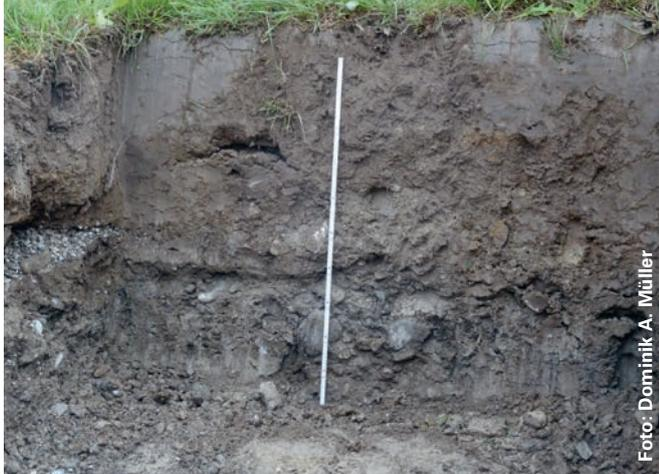
Fertiger Rekultivierungsboden mit 30 Zentimeter Ober- und 50 Zentimeter Unterboden. Unten ist die Rohplanie sichtbar.
