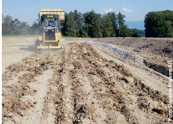
Die Rohplanie wird mit einem Aufreisszahn gelockert, um eine kapillare Trennschicht vermeiden zu können.
