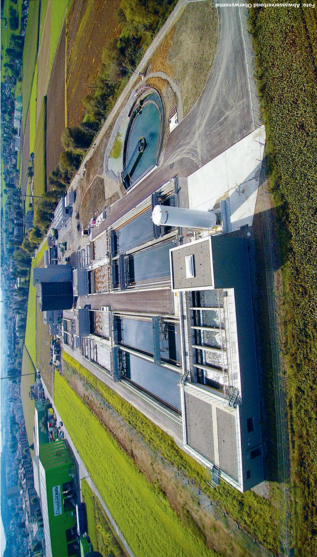
Die ARA Reinach besitzt bereits eine zusätzliche Reinigungsstufe (Ozonung) für die Elimination von Mikroverunreinigungen. Im Vordergrund sind die fünf Becken und das Technikgebäude sichtbar.
