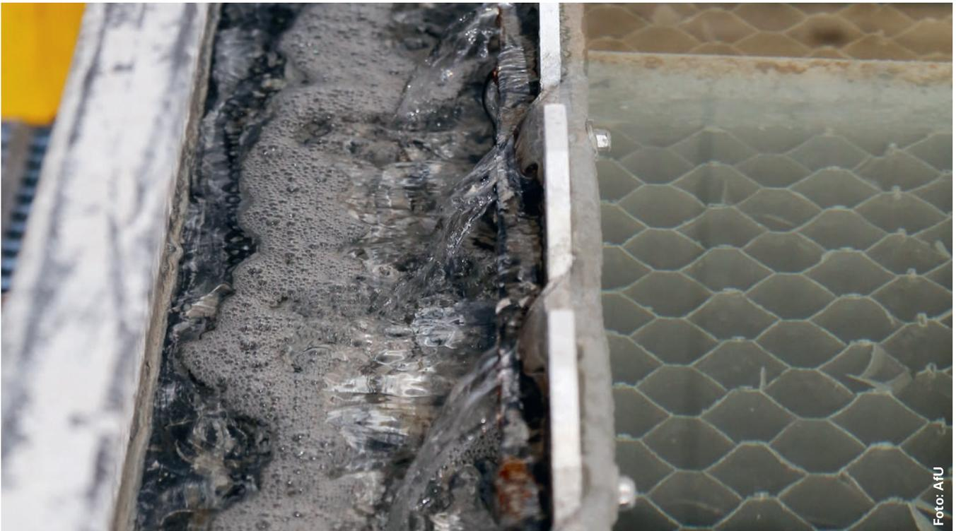
Austritt des gereinigten Abwassers beim Lamellenschrägklärer: Hier werden noch die feinsten Schwebeteilchen aus dem Wasser entfernt.
