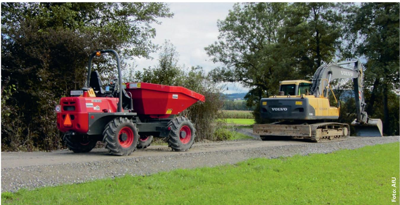
Um witterungs- und bodenunabhängige Arbeiten und Transporte jederzeit zu ermöglichen, wurde unter Anleitung einer bodenkundlichen Baubegleitung (BBB) eine Baupiste aus sauberem Kies direkt auf den gewachsenen und begrünten Oberboden geschüttet. Zur Abtrennung wurde ein Geotextil verwendet.
