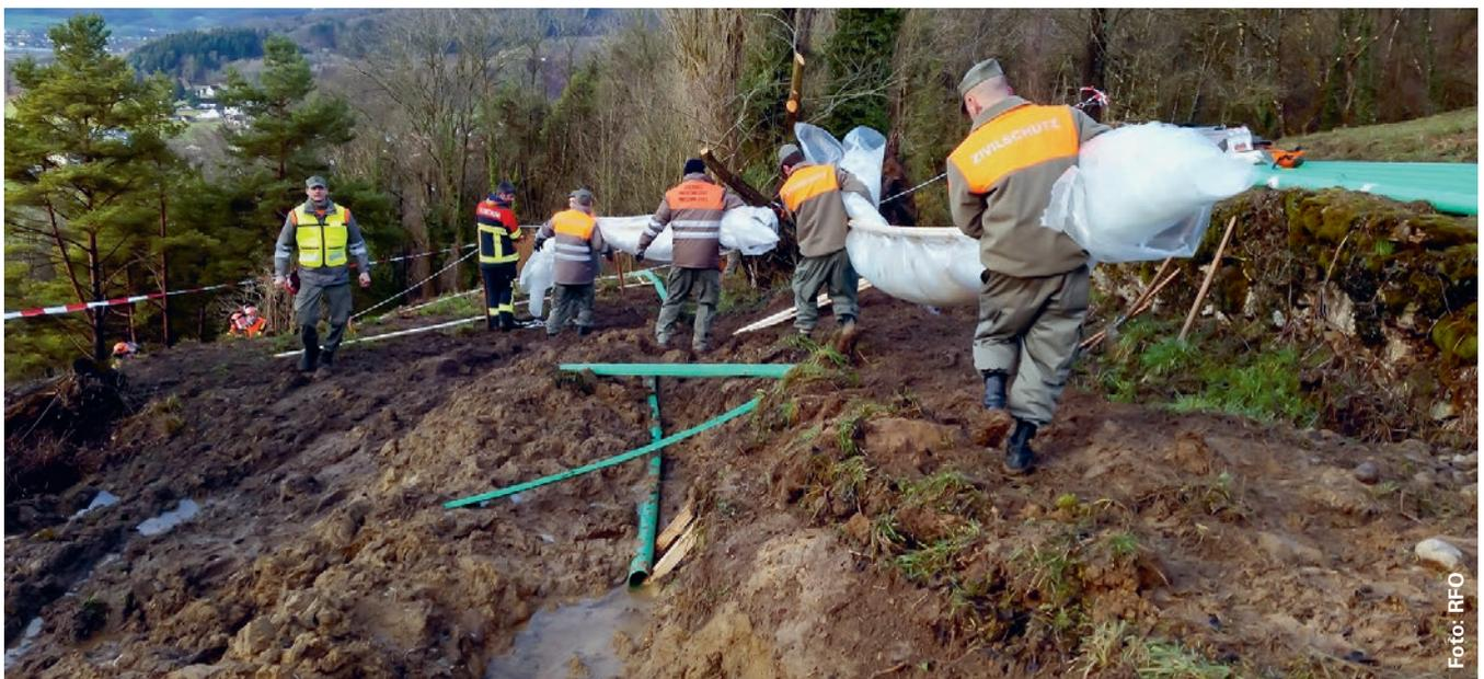
Sofortmassnahmen unter Einsatz des Regionalen Führungsorgans und des Zivilschutzes am 12. Februar 2016: Um das Wasser von der Rutschmasse abzuleiten, wurden als Provisorium PVC-Rohre verlegt.
