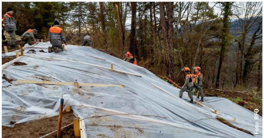
Mit der Plastikfolie sollte verhindert werden, dass Oberflächenwasser in den Rutschkörper eindringt und eine weitere Rutschung verursacht (12. Februar 2016).
