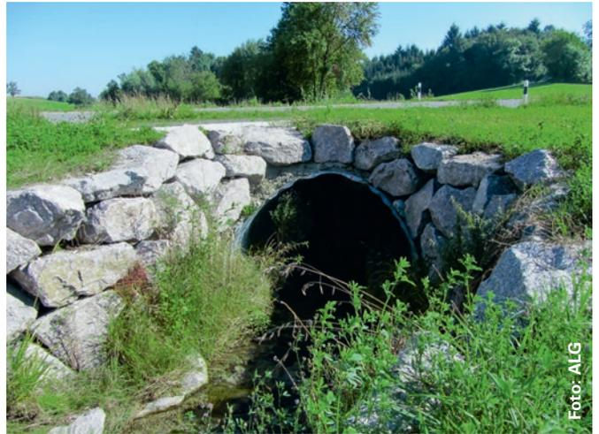
**Massnahmen 4: Vergrößerung Abflussquerschnitt**
