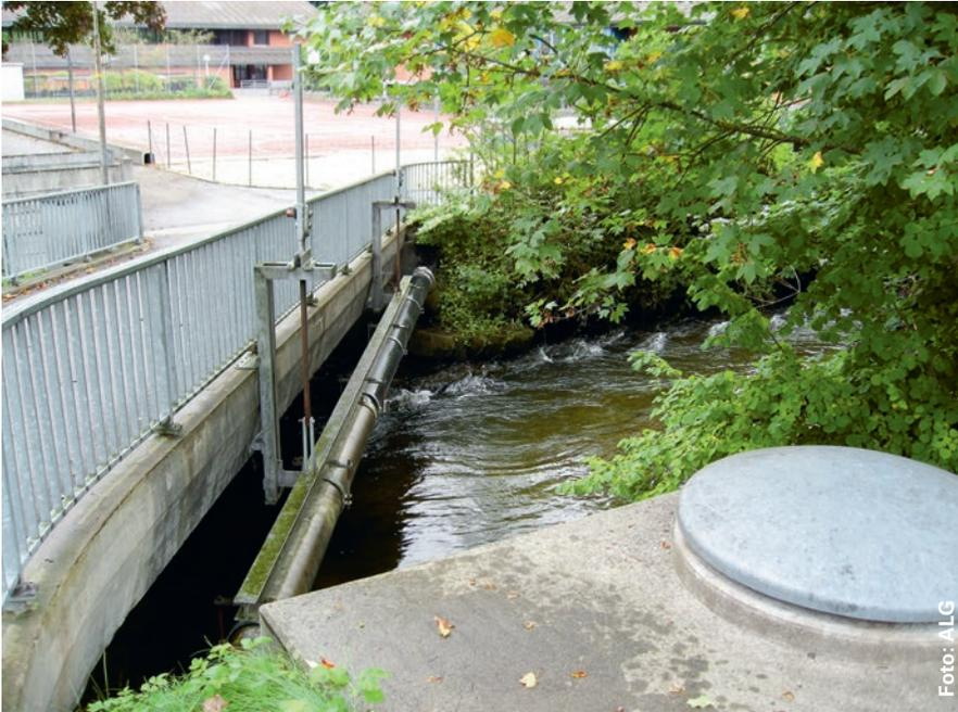
*Bei der alten Paradiesbrücke in Wildegg schränkte eine vorgehängte Kanalisationsleitung das Abflussprofil zusätzlich ein.*
