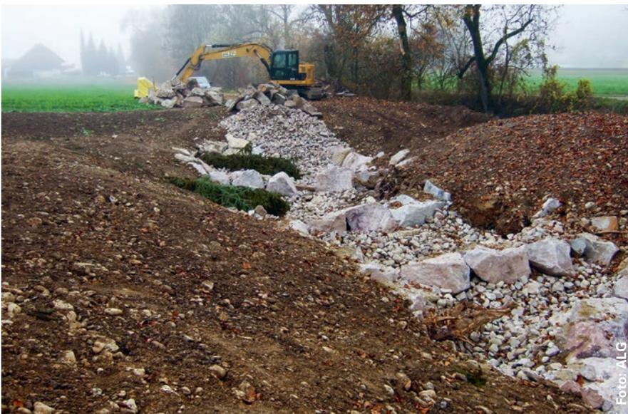
Das Umwegungsgewässer wird als Becken-Riegel-Rampe gestaltet. So entstehen auch strömungsberuhigte Zonen in den Becken.
