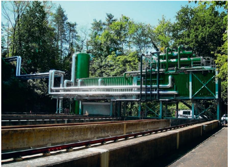
Container mit zwei Wärmepumpen über dem Nachklärbecken der ARA Rheinfelden-Magden.
