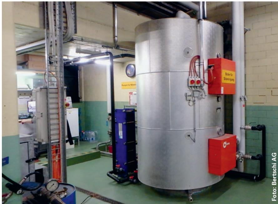
Dem Abwasser wird Wärme entzogen, um damit das Reinigungswasser der Siloanlage aufzuheizen: hier der Boiler mit Wärmetauscher.
