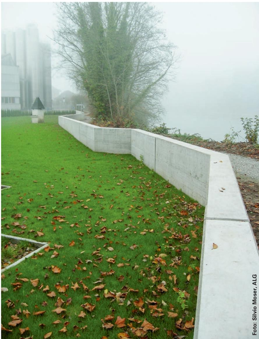
Eine bis einen Meter hohe Hochwasserschutzmauer schützt das Areal der Georg Utz AG.
