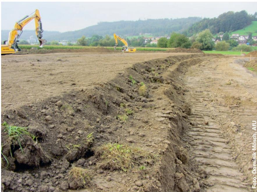
*Aufgrund der Erhebung des Ausgangszustandes wird das Rekultivierungsziel festgelegt. Nach der Erstellung der Rohplanie (rechts im Bild) erfolgt die Schüttung des Unterbodens (mittlerer Bereich) sowie des Oberbodens (linker Bereich), sodass die rekultivierten Flächen mindestens so gute Eigenschaften und Bodenmächtigkeiten aufweisen wie der Ausgangszustand und eine in allen Bereichen uneingeschränkte Nachnutzung möglich ist.*
