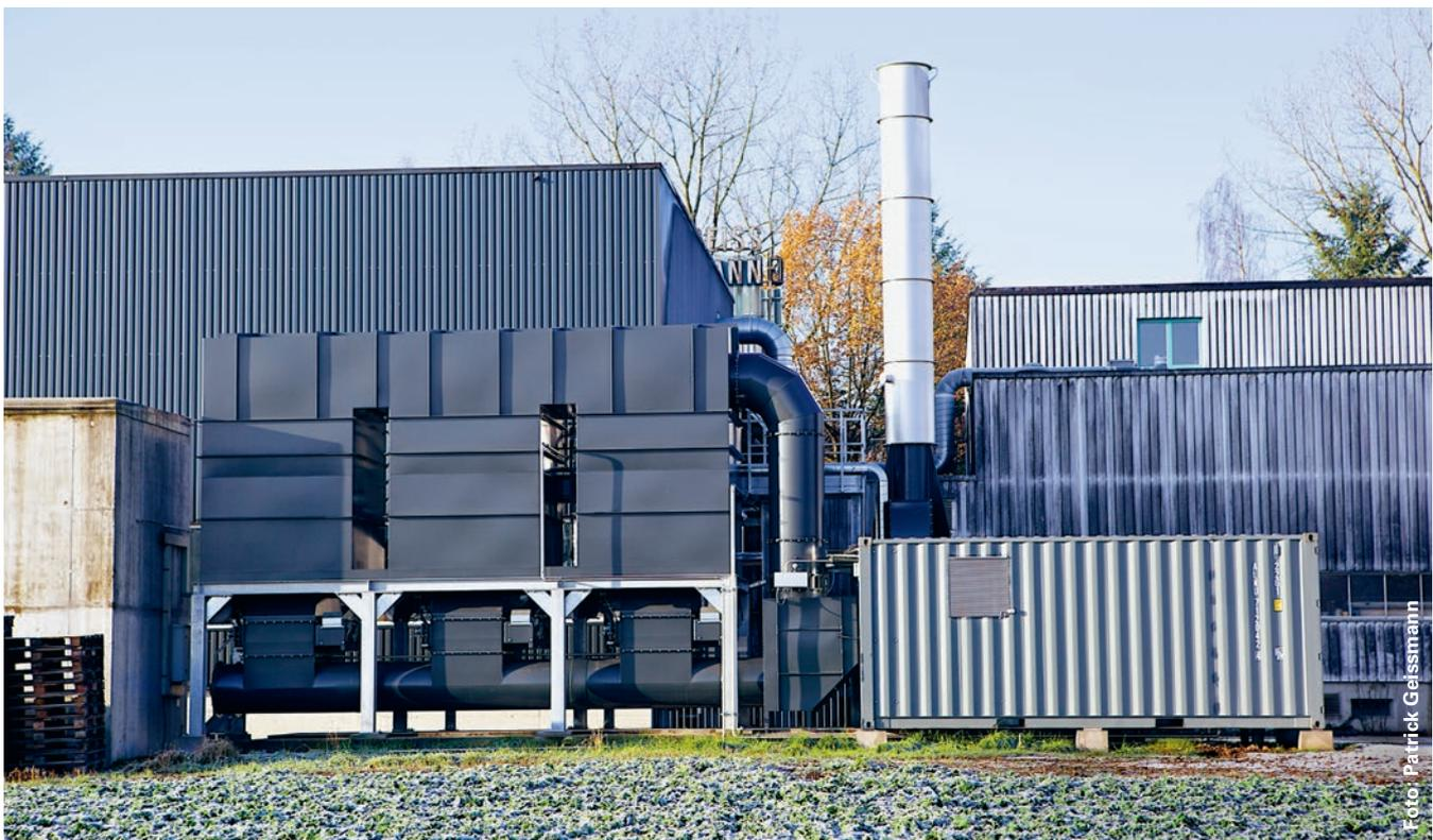
*In einer thermischen oder regenerativen Nachverbrennungsanlage werden VOC aus der Abluft verbrannt. Dabei entsteht zwar Kohlendioxid CO<sub>2</sub>. Doch die Verbrennungswärme wird beispielsweise für Heizzwecke oder Warmwasseraufbereitung eingesetzt, was zusätzlichen Brennstoff einspart.*
