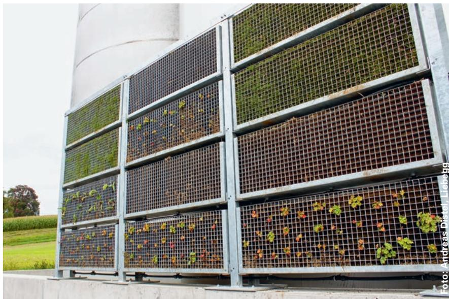
*Biobed- oder Biobaganlagen: Hier werden pflanzenbewachsene Substrate mit pflanzenschutzmittelhaltigen Abwässern bewässert. Die Schadstoffe werden vom Substrat fixiert und von Mikroorganismen abgebaut. Das Fassungsvermögen beträgt zwischen 600 und 100'000 Liter Abwasser pro Jahr. Vom einzelnen Landschaftsgärtner bis hin zur Produktionsgemeinschaft – es gibt für alle Ansprüche die passende Anlage.*
