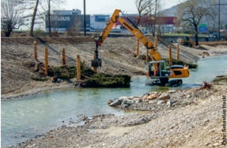
Bau einer Baumbuhne zum Schutz des Ufers und zur Strukturierung des Gewässers
