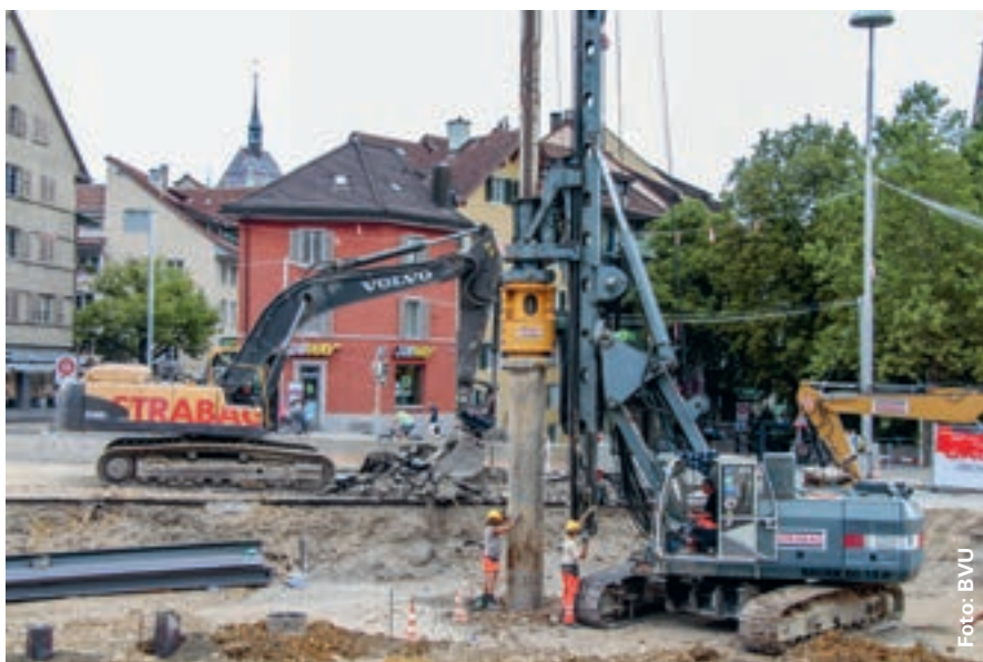
Die Baustelle im Sommer 2015: Blick Richtung Weite Gasse
