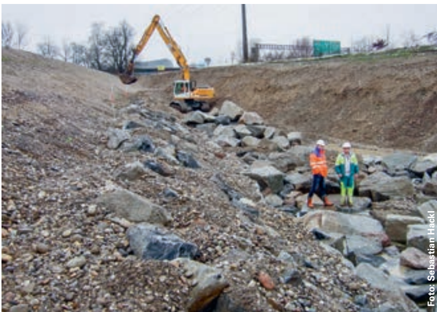
Mit Blocksteinen wird eine Rampe gebaut. Sie dient dem Ausgleich des Höhenunterschieds und der Längsvernetzung.
