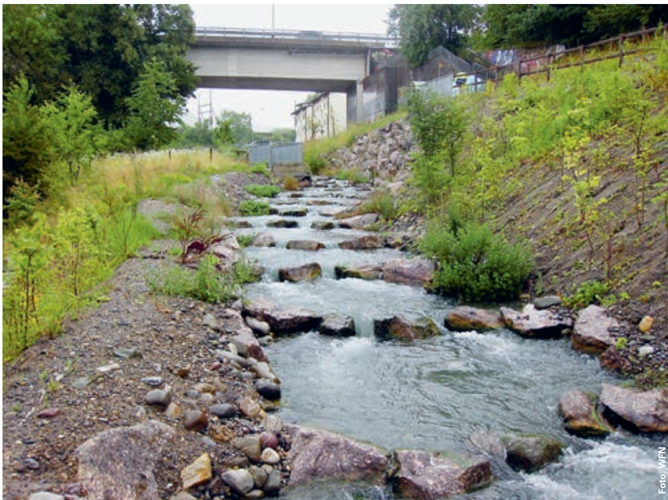
Naturnaher Beckenpass als Fischaufstiegshilfe beim Kraftwerk Wettingen
