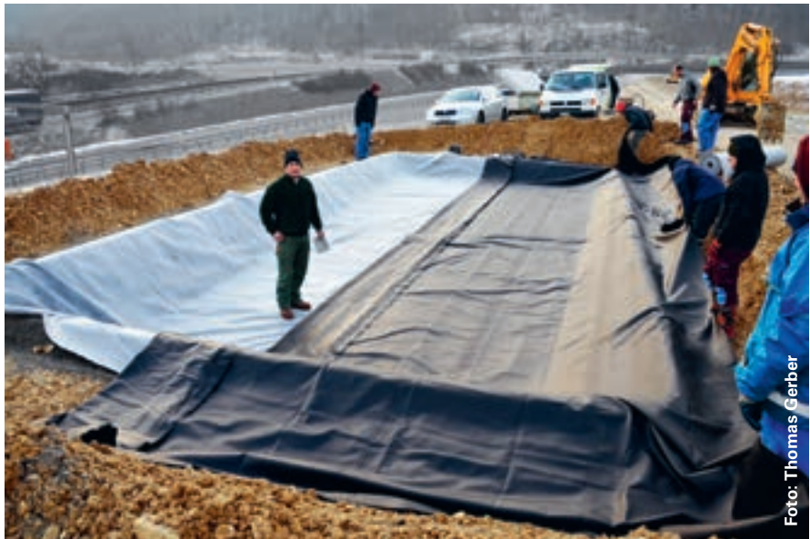
Entstehung eines Ablass Weihers: Die Kautschukfolie wird in die ausgebagerte Wanne gelegt.
