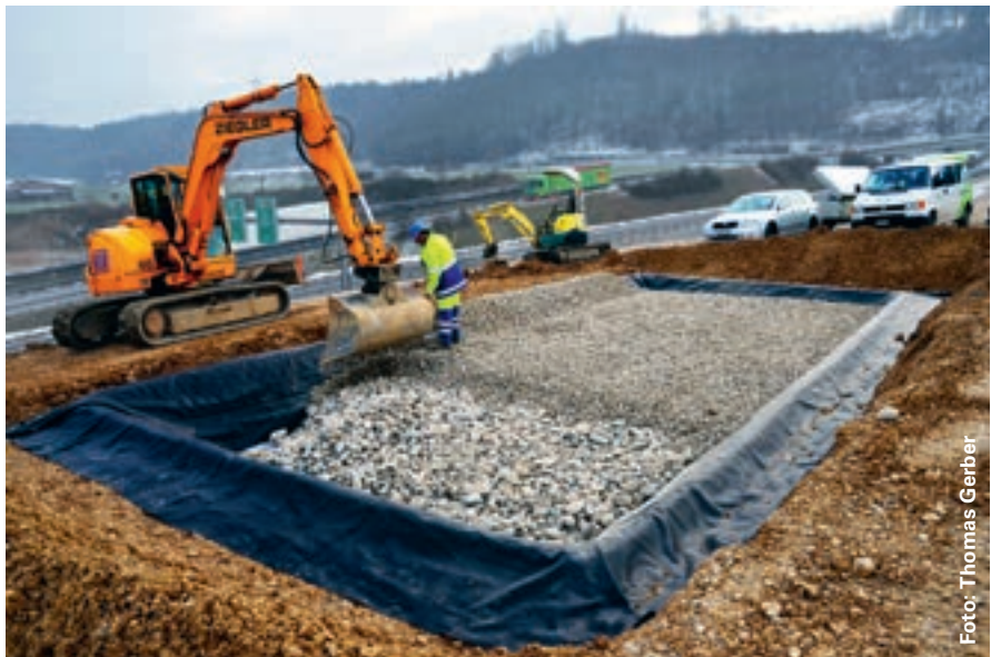
Der Bollenstein- und Schotterkörper dient als Wasserspeicher.
