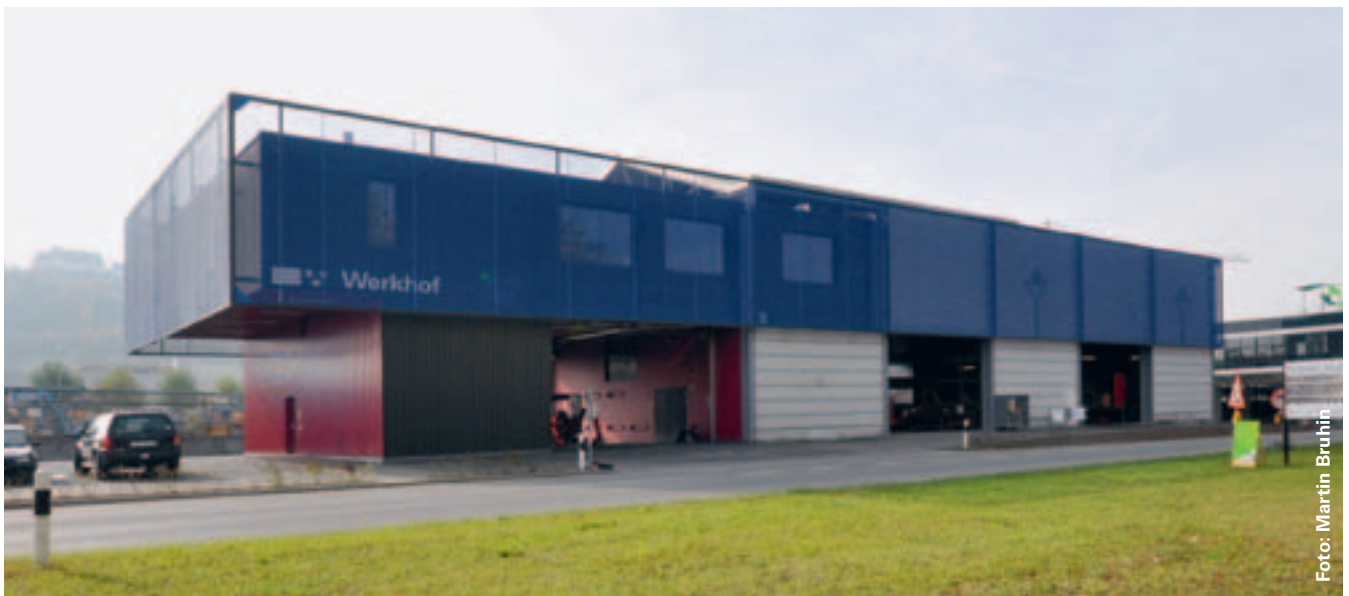
Beim Bau des Werkhofs des Strassenunterhalts in Lenzburg – das zweite zertifizierte Minergie-Eco-Gebäude im Kanton Aargau – konnten nahezu 100 Prozent Recycling-Beton eingesetzt werden. Auch die Zuschlagstoffe zum Beton bestehen zu 80 Prozent aus rezyklierten Stoffen.
