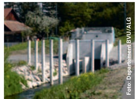
Hochwasserrückhaltebecken Moos in Gontenschwil/Zetzwil: Auslasstyp Mönch mit Schacht als Hochwasserentlastung
